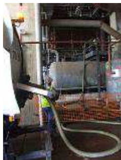
purge d'une cuve à l'aide de l'hydrocureur
