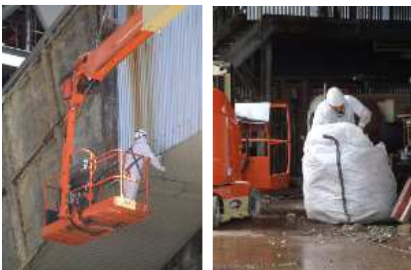
décalorifugeage d'un réchauffeur stockage du calorifugeage en big-bag
