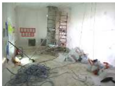
traitement sur place
