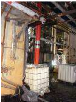
purge d'une canalisation BTS
