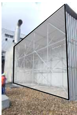
entrée du compresseur d'air de l'acide nitrique
