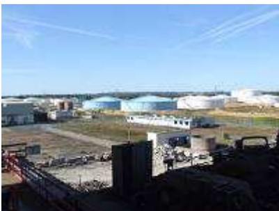
cuves SPBA vues de la centrale
