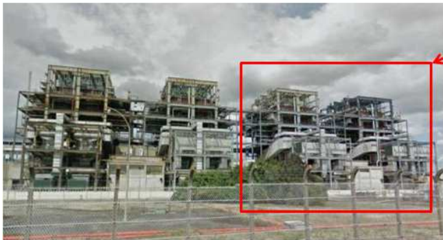
Chaudières abattues lors du 2 ème tir (4 avril 2014)
