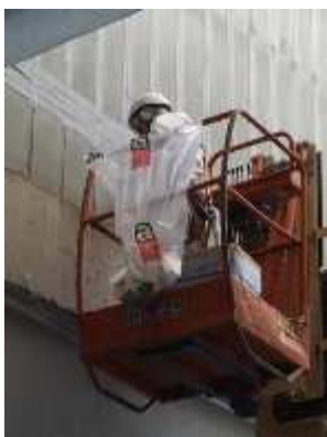
dépose mastic bardage vitré
