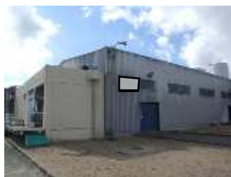
bâtiment des utilités abritant les compresseurs d'air « service »
