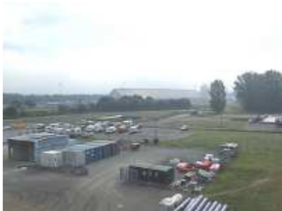
site YARA vu de la centrale
