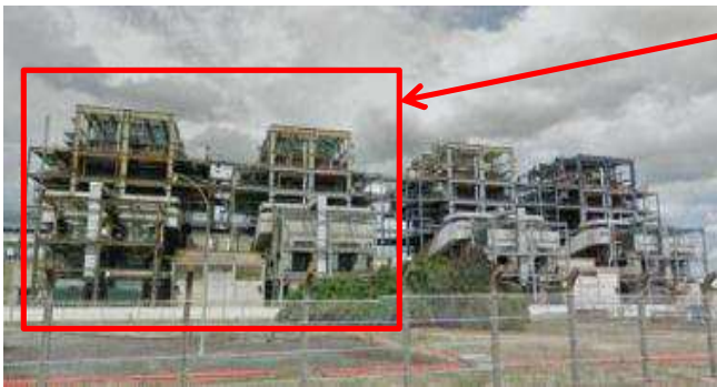
Chaudières abattues lors du 1 er tir (22 novembre 2013)
