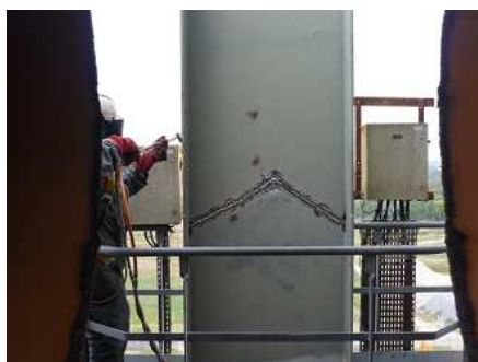
Coupe droite complétée en V sur les ailes et fibre
