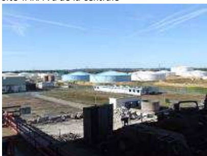
site SPBA vu de la centrale
