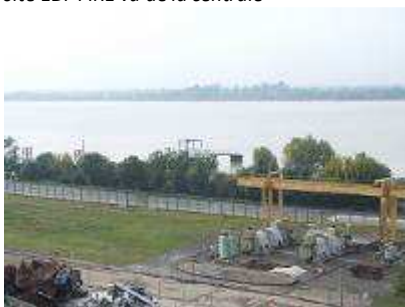
zone d'apportement utilisée par la Société de Lamanage, vue de la centrale
